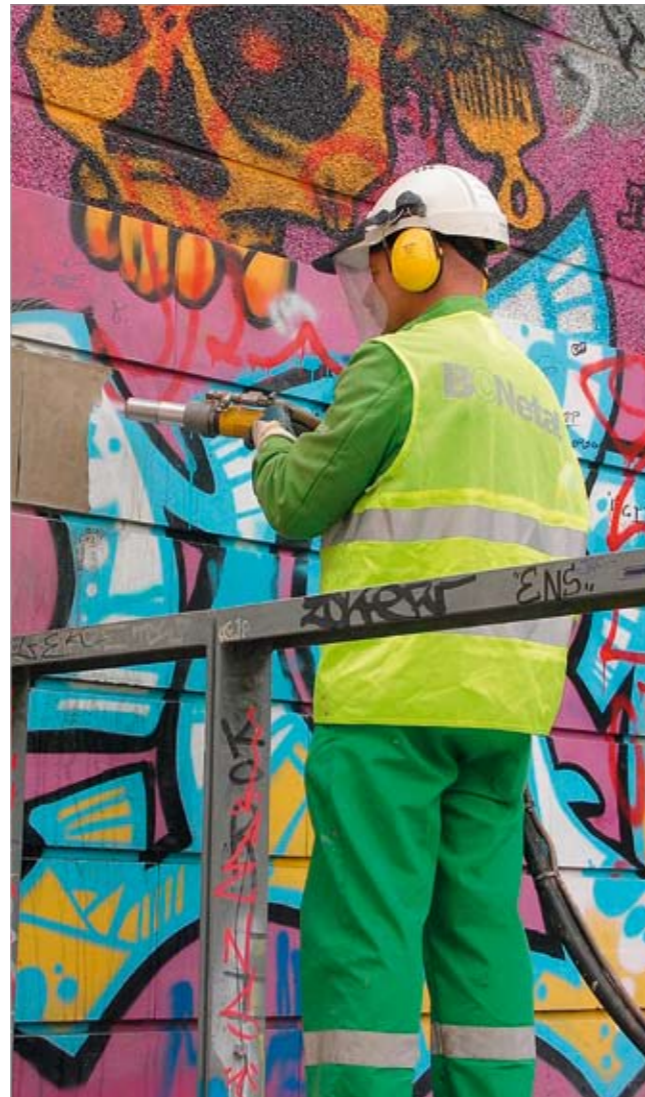
Eliminación de Graffiti
