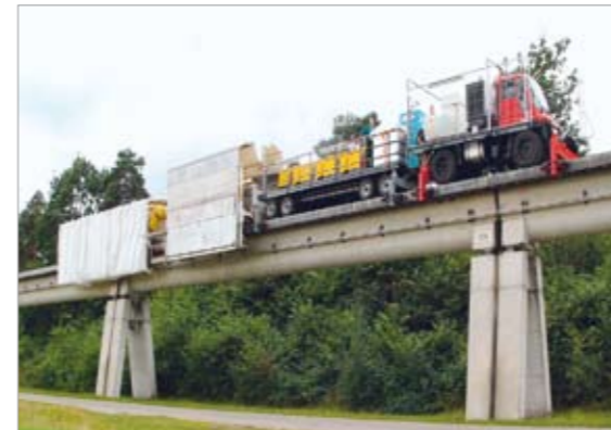
Un Unimog aplica una capa de material protector a lo largo de las vías del Transrapid con la ayuda de compresores KAESER M 76; lleva unos soportes laterales que evitan que se caiga de la vía
