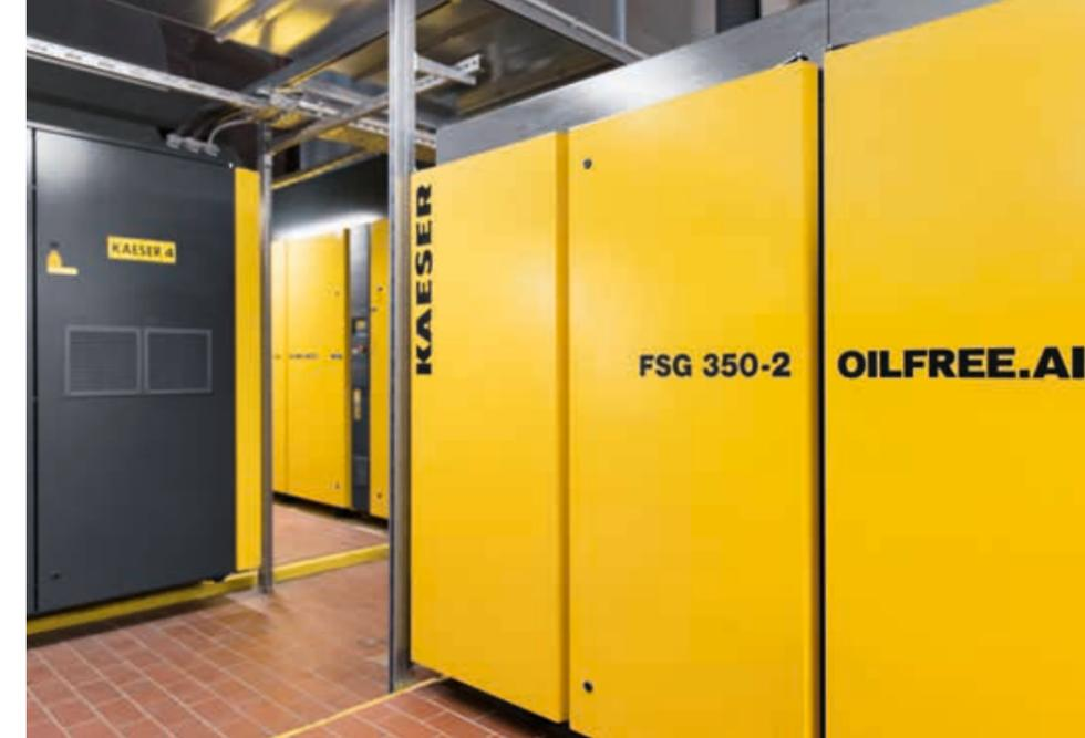
El aire comprimido cumple funciones vitales en la planta de Hannover. Sirve, entre otras cosas, para el transporte del óxido de plomo.
