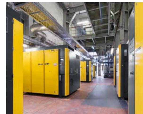
En la estación de aire comprimido hay instalados cuatro compresores de tornillo con el eficiente PERFIL SIGMA y motores IE4.
